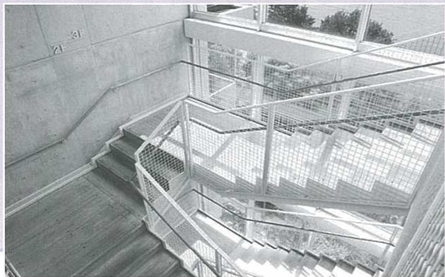
▼海側に面した階段はガラス張りで見晴らしもよい
